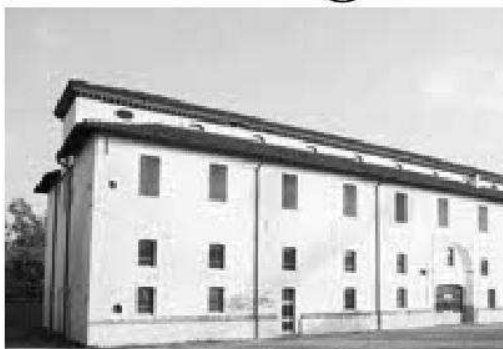
Particolare del palazzo del Noviziato di Ospedaletto Lodigiano
